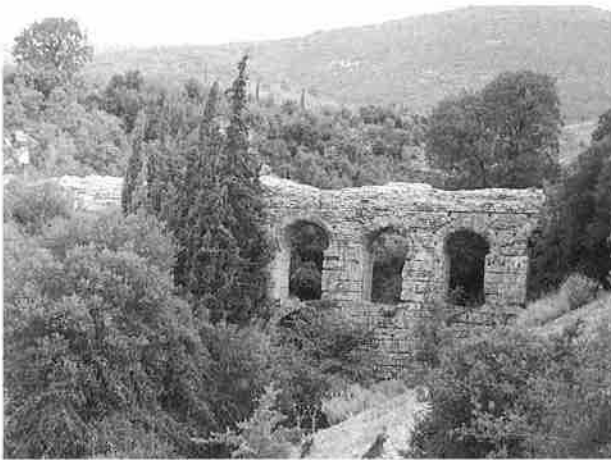
Η υδατογέφυρα του Αδριανείου Υδραγωγείου στο Στρογγυλό της Νεμέας.
