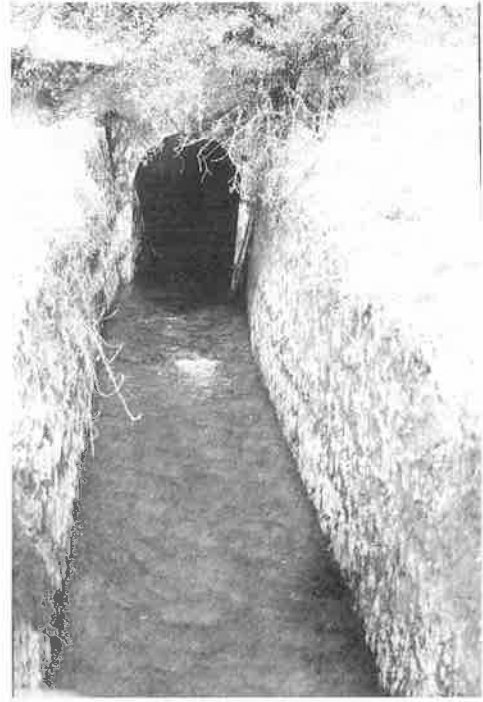
Αριστερά. Το μεγάλο αυλάκι φέρνει το νερό των πηγών της Στυμφαλίας στην είσοδο του αγωγού του Ανδρανείου ορύγματος. Δεξιά. Η έξοδος του νότιαγωγείου στο πίσω μέρος των διάσελων Σιούρι.
