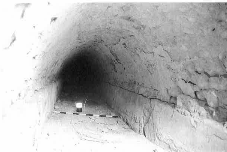
Εσωτερικό του αγωγού στο Σταλιό.
