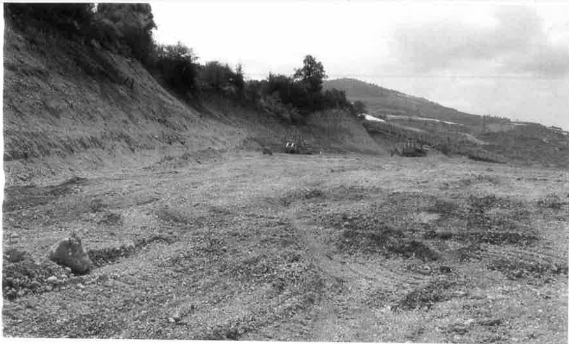
Στιμάγκα Κορινθίας: ο μηχανικός εκσκαφέας επί το έργο.
